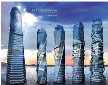
modificare costantemente. Sarà costituito da 80 piani indipendenti, ciascuno in grado di ruotare di 360° attorno alla struttura centrale e avrà un'altezza complessiva di 420 metri. Ogni piano della torre è un insieme di moduli singoli prefabbricati. Ognuno degli occupanti potrà controllare il movimento del proprio loft attraverso comandi vocali. Costerà più di 700 milioni di dollari e per ora sembra ancora una visione futuristica. Non ci resta che aspettare il 2020!
